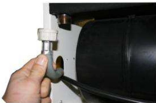
3 Подсоединить трубу слива конденсата.
